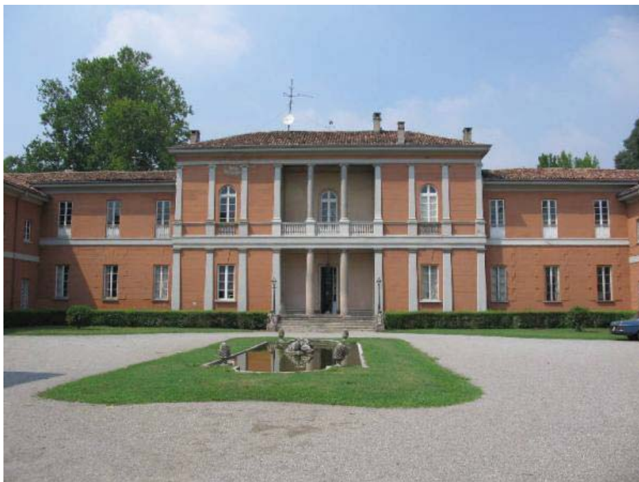
(2006) Prospetto del corpo principale verso il cortile
