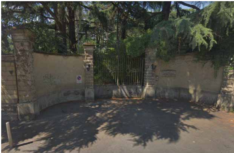
Ingresso su via Cesari
