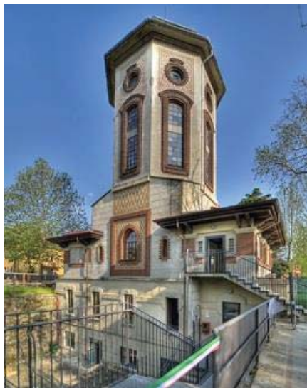
La torre dell'acquedotto
