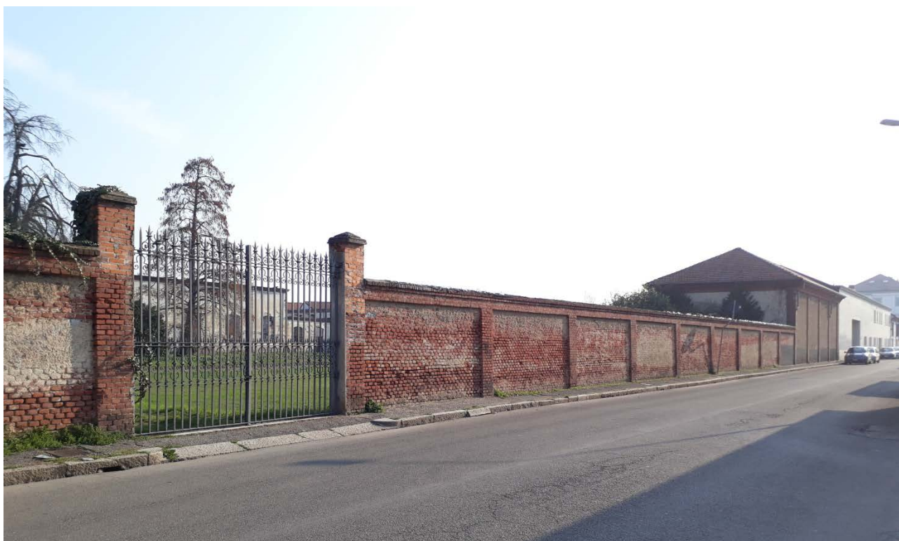
CANCELLO CARRAIO INGRESSO DIRETTO DA VIA ROVERETO
