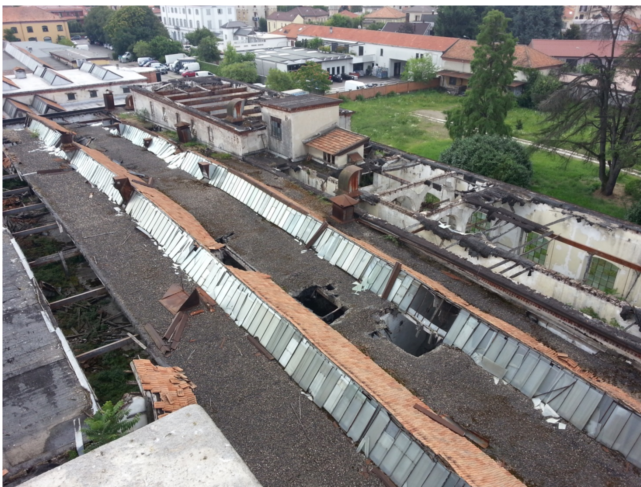
VISTA PORZIONI DI COPERTURE
