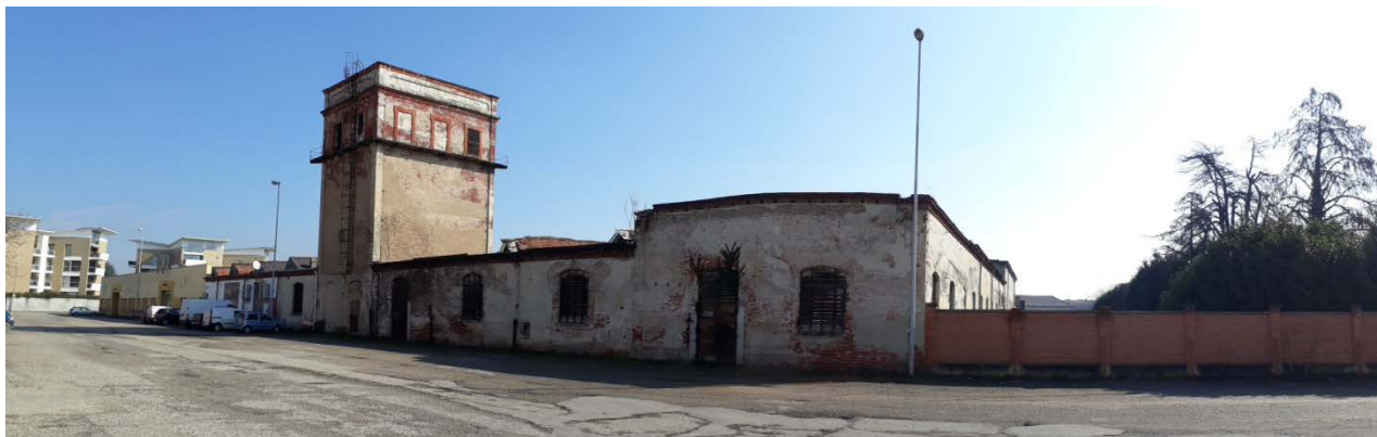
FRONTE FABBRICATO E TORRETTA SU AREA CARRAIA CONDOMINIALE
