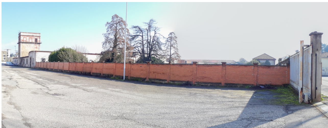
TUTTO FRONTE INTERNO SU AREA CARRAIA CONDOMINIALE
