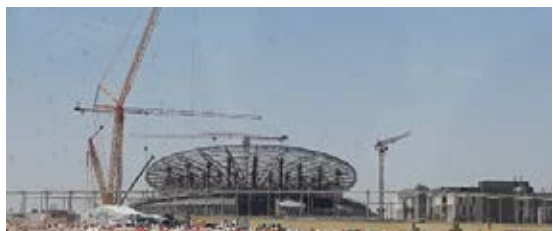
Sito in costruzione nel 2019
