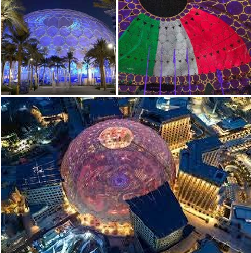
Cupola Al Wasl realizzata da Cimolai Rimond
