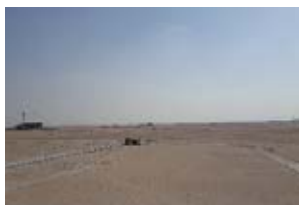
Sito in costruzione nel 2016
