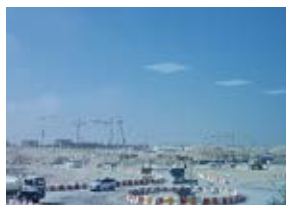
Sito in costruzione nel 2017
