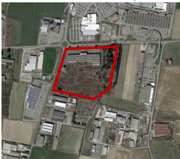
Figura A.9 Area dimessa ex Colussi in Comune di Torrazza Coste (100.000 m2 circa di superficie fondiaria)
