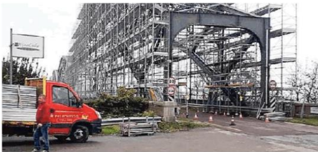
I cantieri di risanamento sul ponte della Gerola
