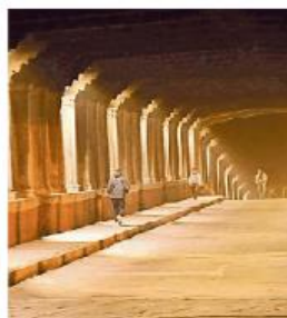
IL PONTE COPERTO DI PAVIA È UNO DEI LUOGHI DELLA CITTÀ IN CUI È VIETATO SOSTARE A LUNGO
