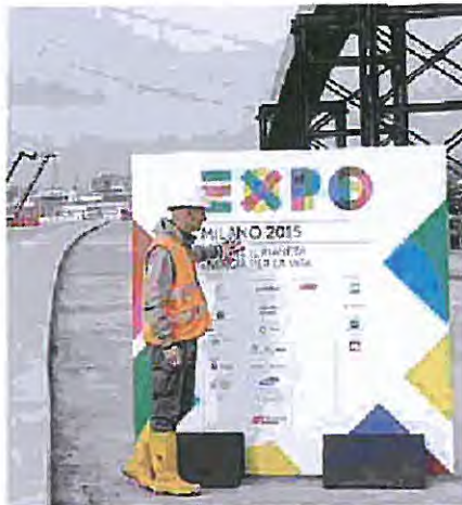
AL LAVORO Un operaio sul cantiere di Rho-Però, dove si svolgerà l'Expo (Newpress)
